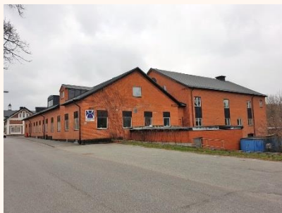
Ångpannebyggnaden där det fanns två ångmaskiner.
