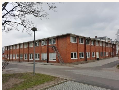
Byggnaden där ekonomibyggnaden fanns förut.
