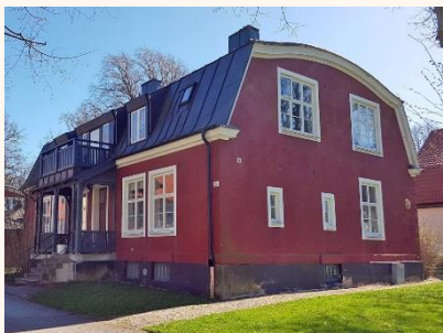
Ett av de två bostadshus som byggde 1908–1909.
