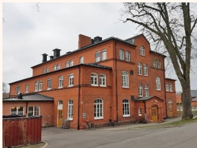
Byggnaden för tvätteriet.
