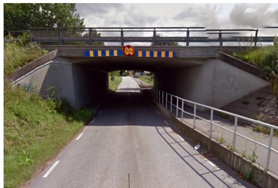
Tunneln på Stora Uppåkravägen under motorvägen E22. Källa: Google Maps.
